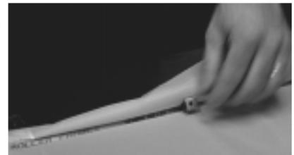
**Rodillo (corto) #2:** Tirando suavemente de la malla hacia Ud., inserte 3 grapas de alineamiento en la ranura "T"; una a cada extremo de la ranura "T", y la tercera grapa en el centro. Inserte la tira sujetadora, de derecha a izquierda, siguiendo como anteriormente.
